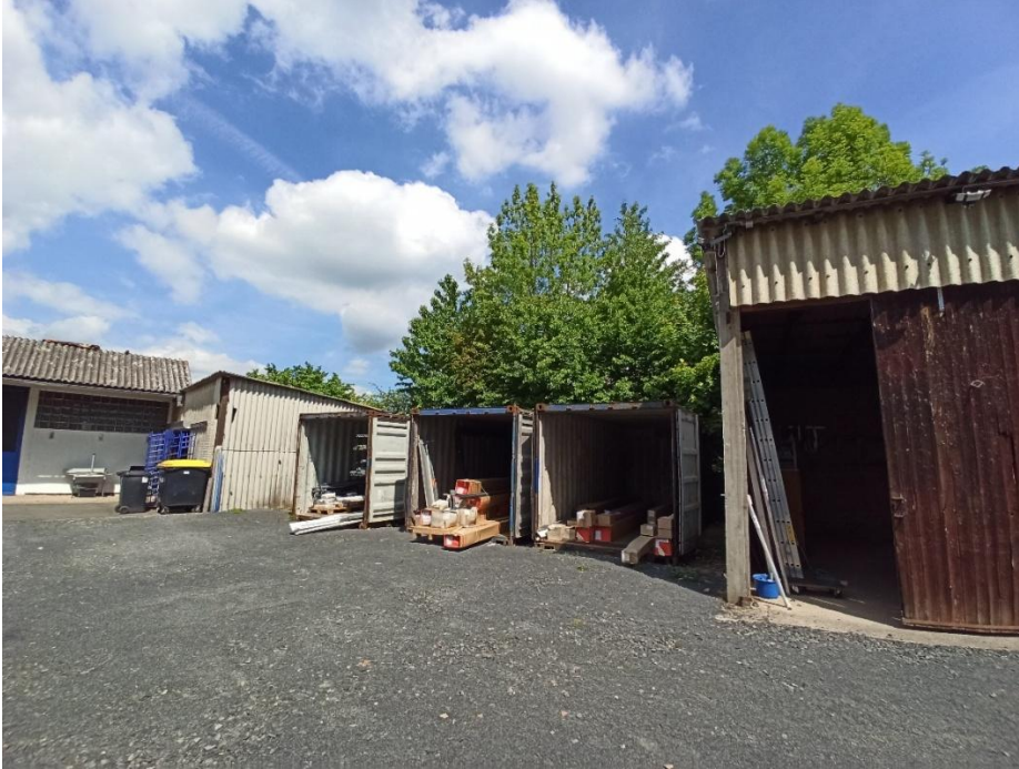
Abb. 3-13: Lagerflächen des östlichen Grundstücks
