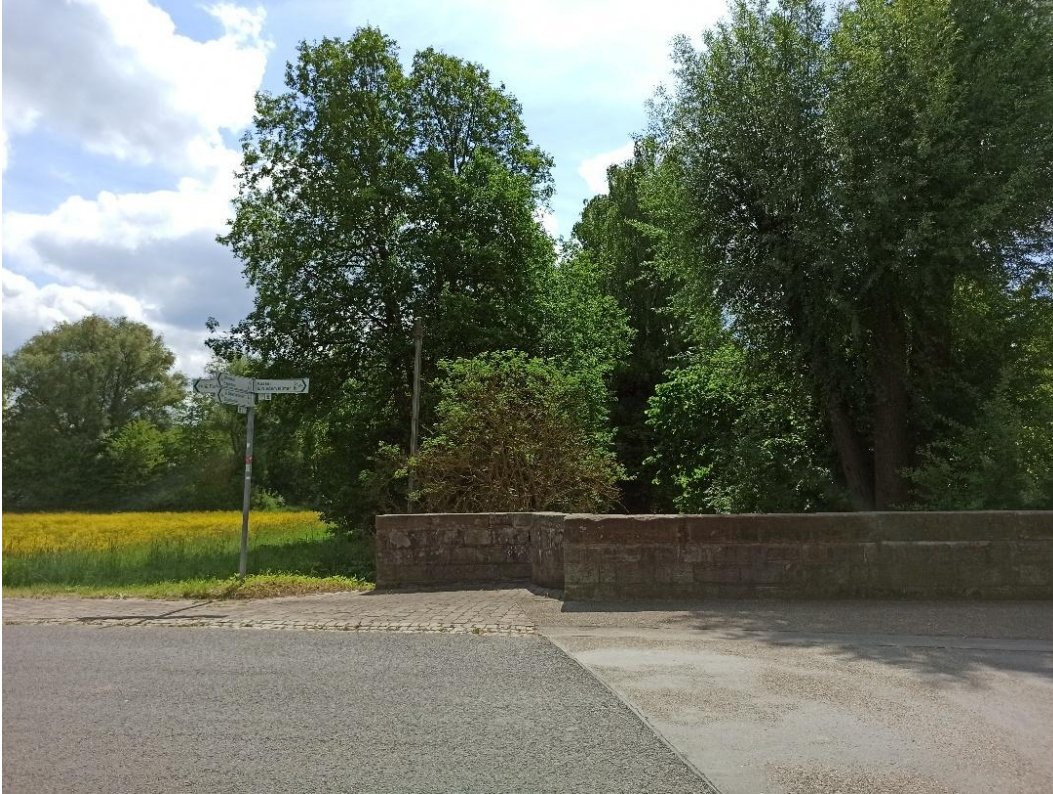
Abb. 3-22: Im Anschluss an die Brücke der Ihringshäuser Straße weisen die Ufer der Ahne einen naturnahen Ufergehölzbewuchs auf
