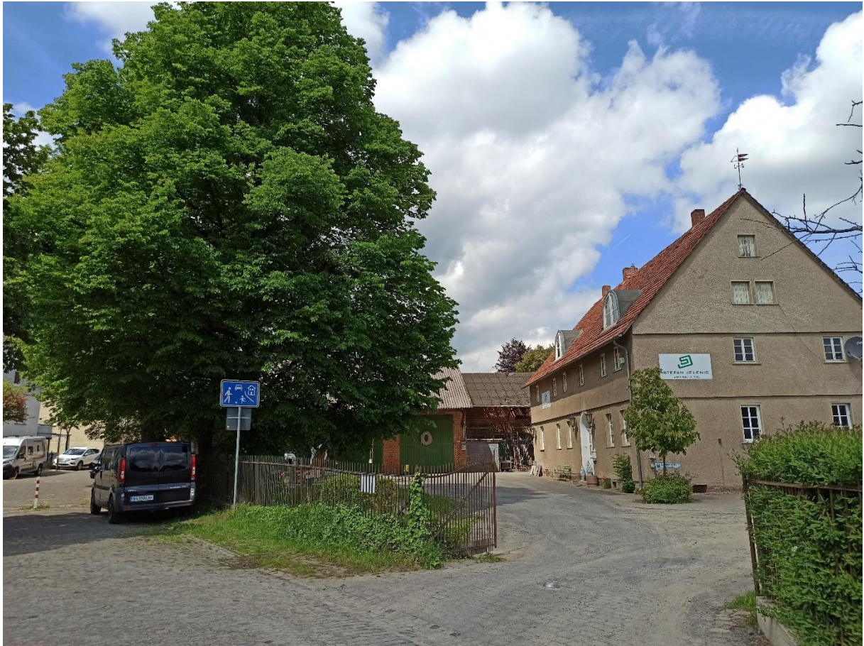
Abb. 3-28: Blick von der Straße zum Wohngebäude
