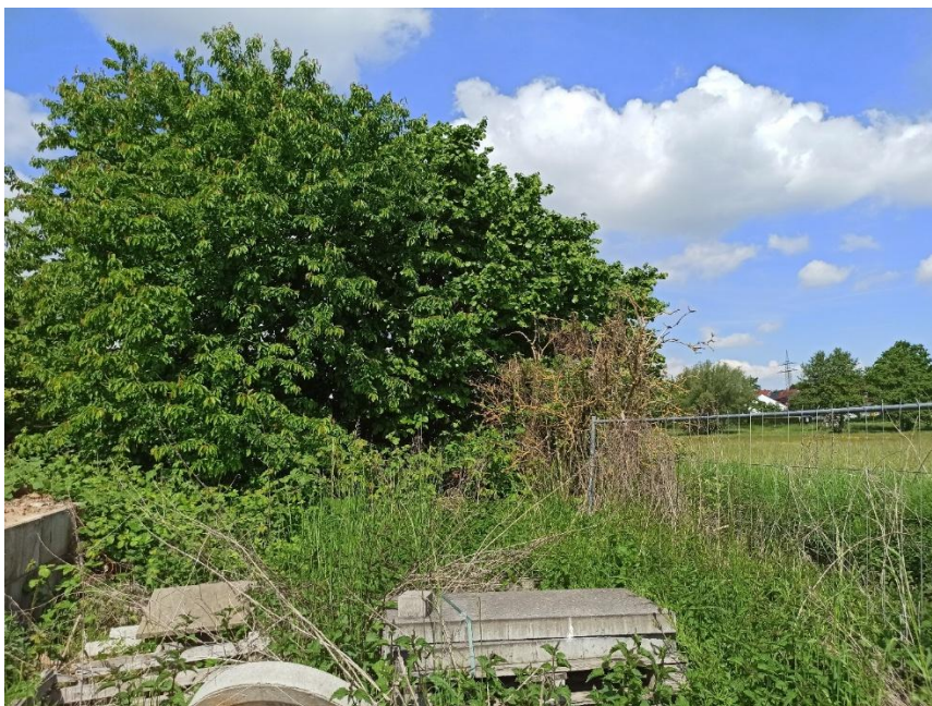
Abb. 3-16: Übergang zum Ahneufer (jenseits des Bauzauns)
