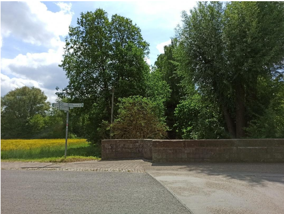
Abb. 3-23: Im Anschluss an die Brücke der Ihringshäuser Straße weisen die Ufer der Ahne einen naturnahen Ufergehölzbewuchs auf
