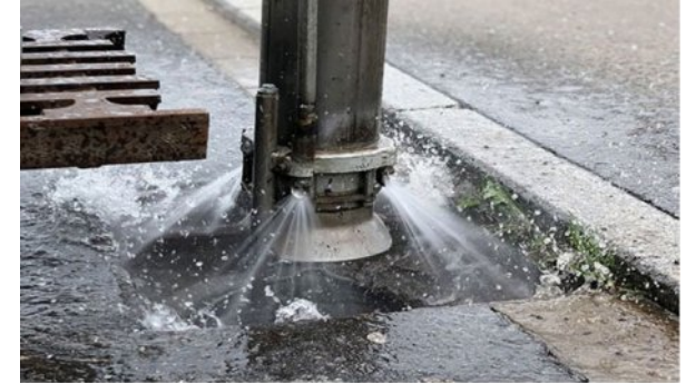
Sinkkastenreinigung, Quelle: Kappler Umwelt-Service GmbH
