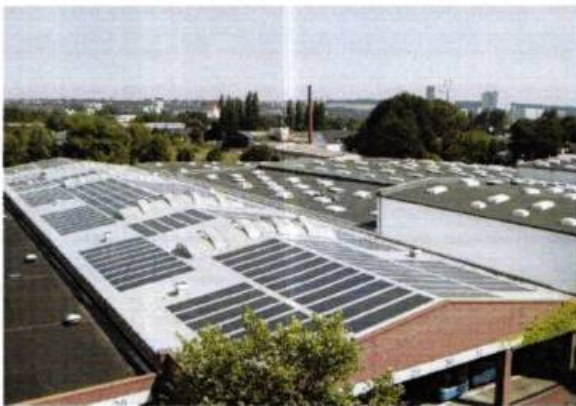
Abbildung 3: KVG-Betriebshof Kassel; PV-Anlage als Foliendach (alwitra GmbH & Co. KG, o.J.)
