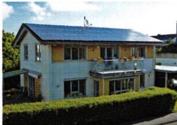
Abbildung 4: Haus in Kassel; PV-Anlage 9 kWp
