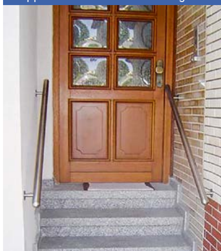
Treppe mit Handläufen beidseitig
