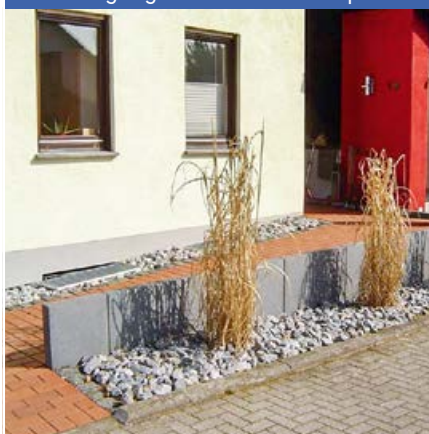
Hauseingang nachher: mit Rampe
