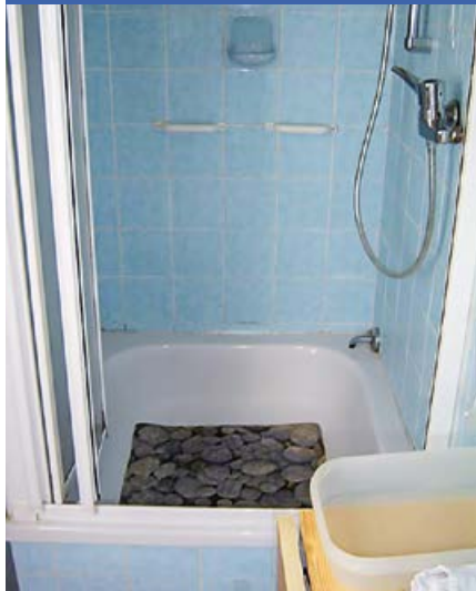
Dusche vorher: mit hohem Einstieg
