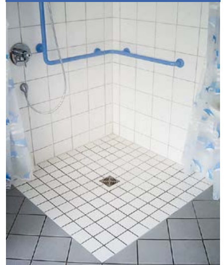
Dusche nachher: ebenerdig
