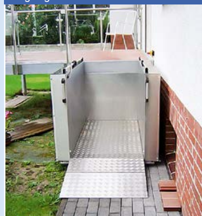
Zugang mit Plattformlift
