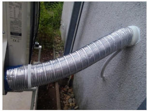
Montage körperschallentkoppelt
