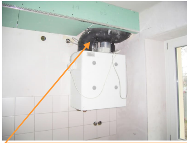
Frischluft- und Fortluftkanal je 1,20 m
