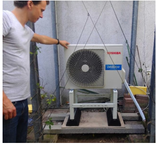
Montage körperschallentkoppelt
