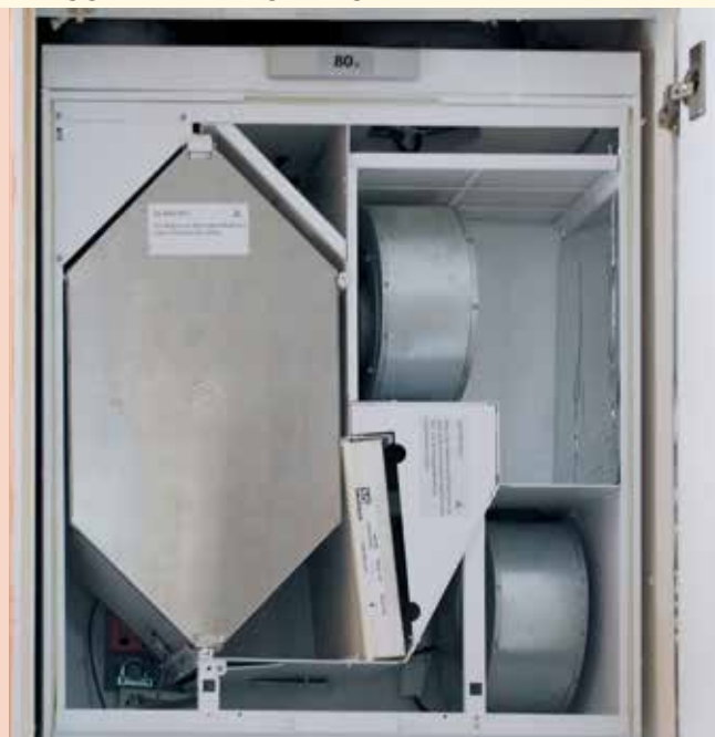
Lüftungsgerät mit Wärmerückgewinnung
