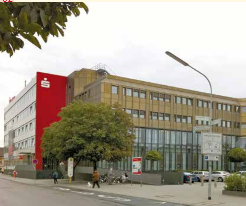
Verwaltungsgebäude | Altbau vor der Sanierung
