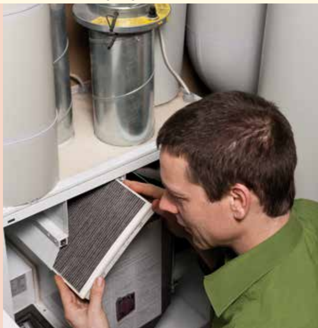
Filterwechsel an der Lüftungsanlage
