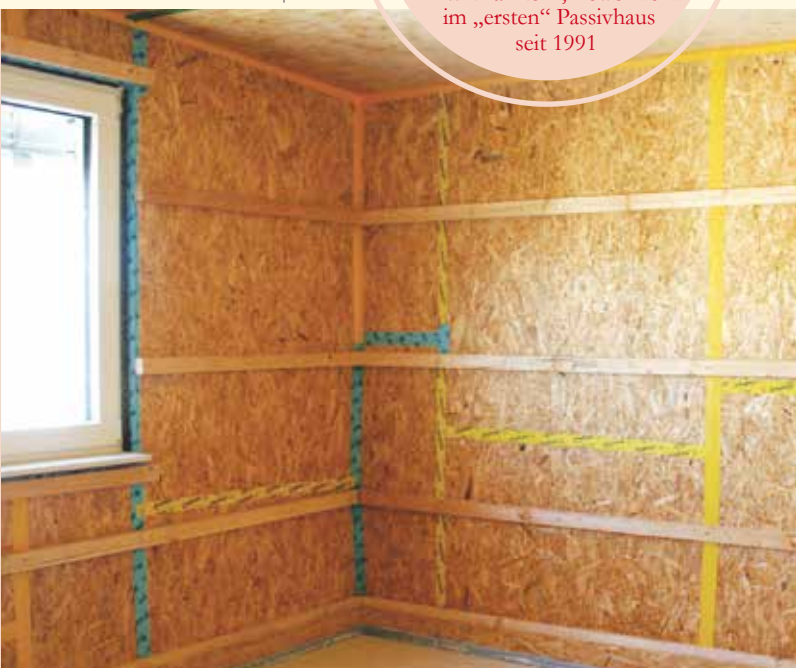
Luftdicht verbundene Holzwerkstoffplatten
