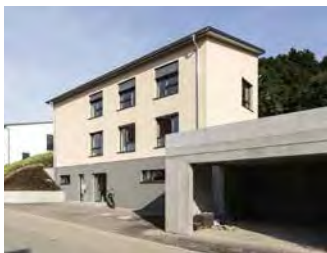
77716 Haslach ID 2903 Freistehendes Einfamilienhaus
