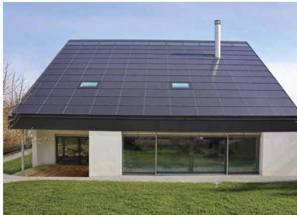
Abbildung 55: Foliensolarmodule für geringe Dachlasten (alwitra GmbH & Co. Klaus Göbel, 2017)
