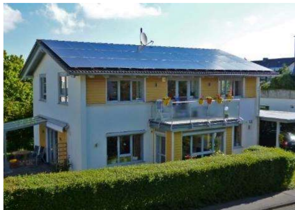
Abbildung 4: Haus in Kassel; PV-Anlage 9 kWp
