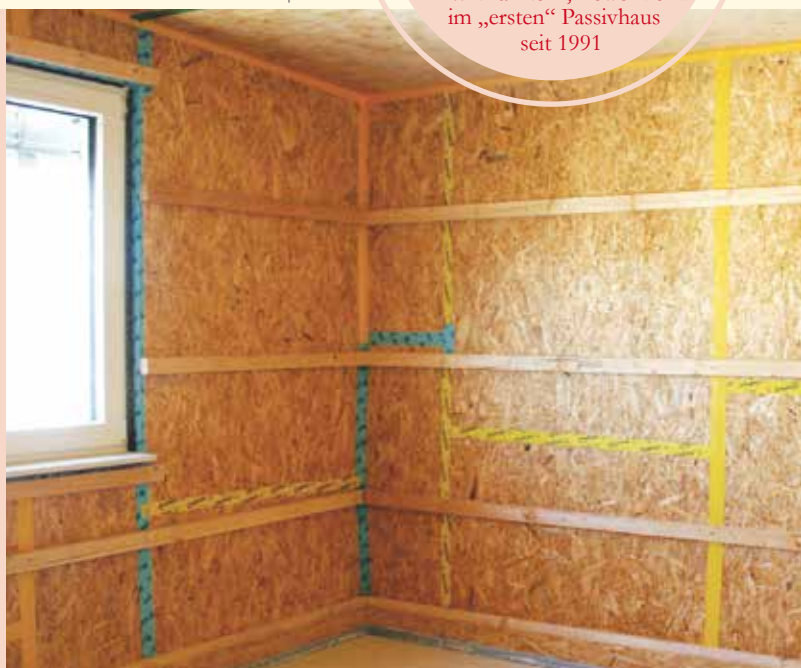
Luftdicht verbundene Holzwerkstoffplatten
