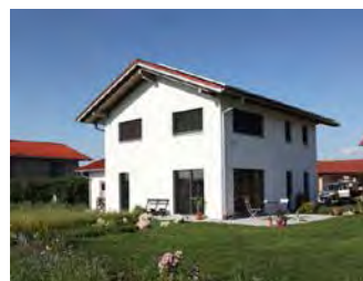
83361 Kienberg ID 2797 Freistehendes Einfamilienhaus
