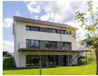
77915 Elzach ID 2904 Freistehendes Einfamilienhaus
