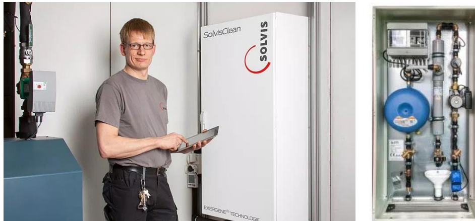
Abbildung 70: Ultrafiltrationsanlage Solvis-Clean (SOLVIS GmbH, 2017)
