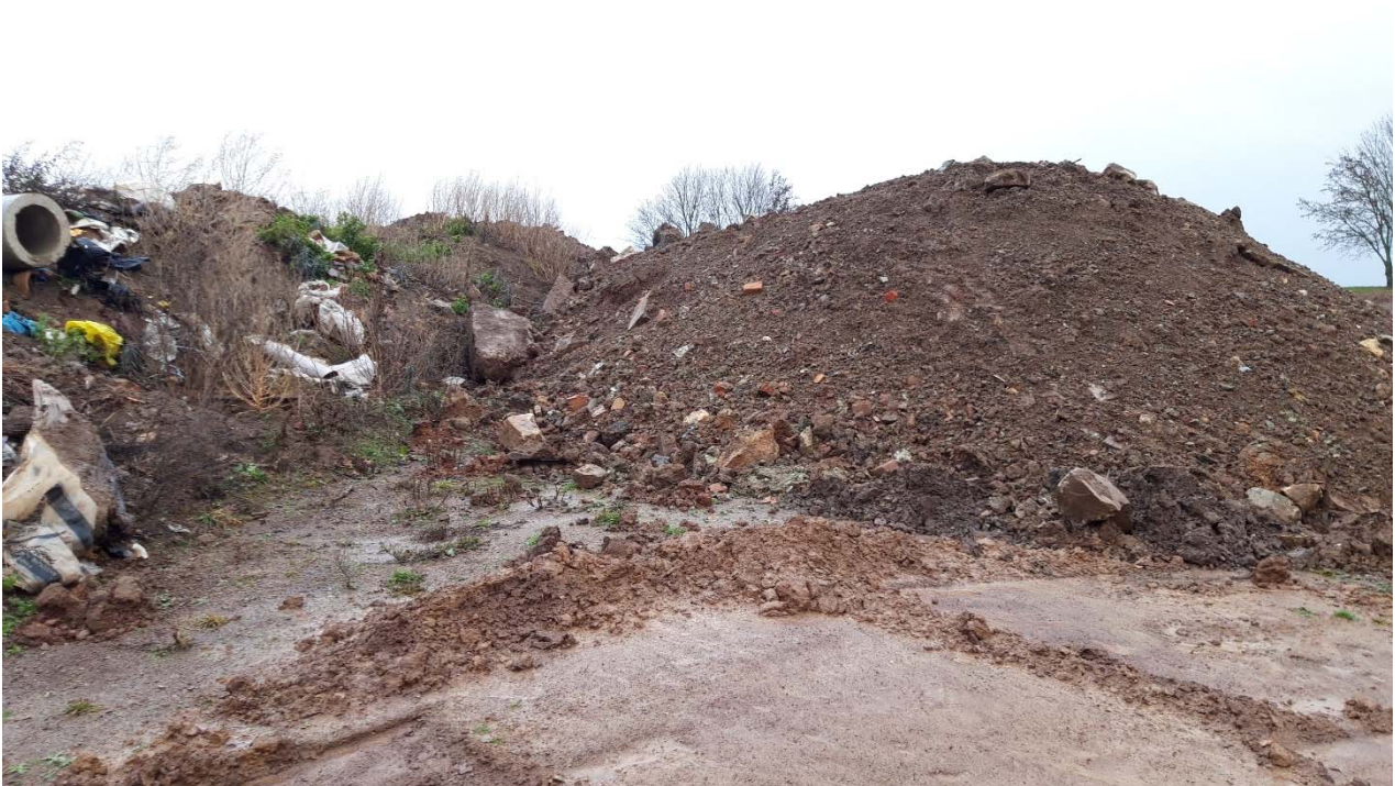
Bild 5: Haufwerk 4 - Aushub aus RRB 2 mit hausmüllähnlichen Bestandteilen (links)
