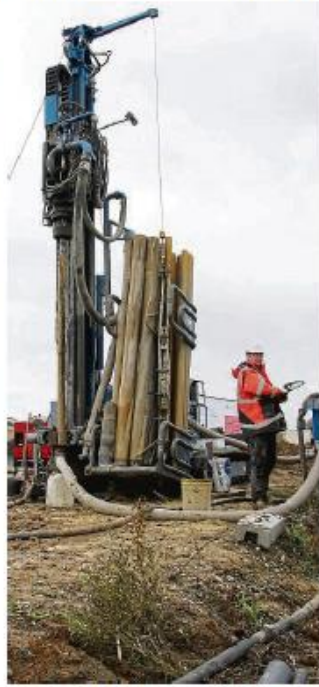
Das Bohrgestüt gräbt sich bis zu 100 Meter tief. Für die Testbohrung werden insgesamt drei Tage benötigt. Mit den ermittelten Daten können die Geologie und die Wärmeleitfähigkeit des Erdreiches ermittelt werden.
