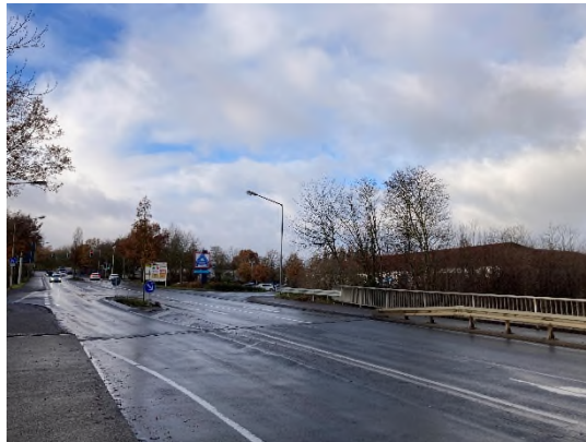
Foto 2: Hauptzufahrt zum Projektstandort, Straße Zum Feldlager, Blick Richtung Westen
