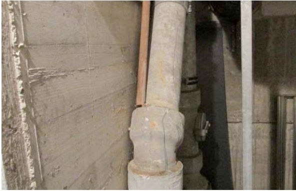
3. Schadhafte Asbestzementleitung
