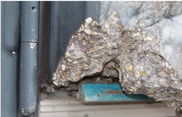
4. Schadhafte Betonfassade
