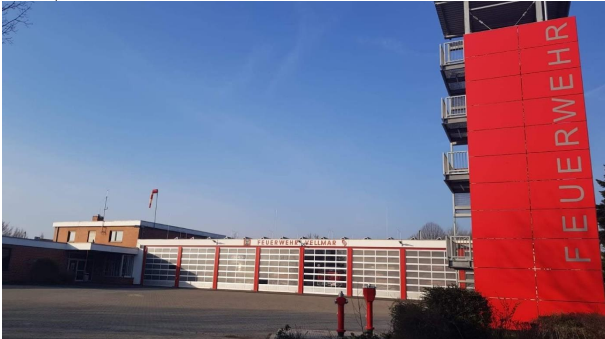
Foto: Feuerwehrhaus in der Brüder-Grimm-Straße mit Übungsturm
